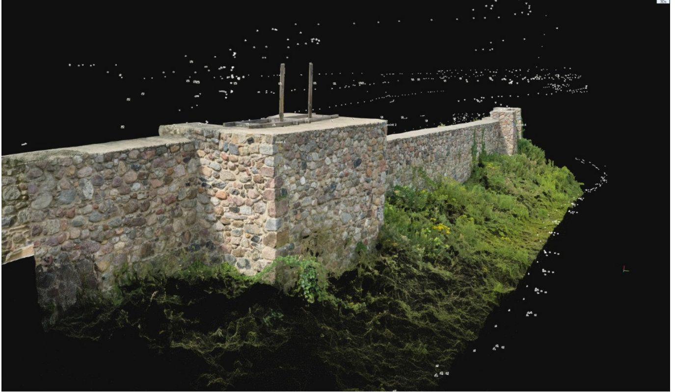
Point cloud image from a photogrammetric model / Biuro Dokumentacji Zabytków.
