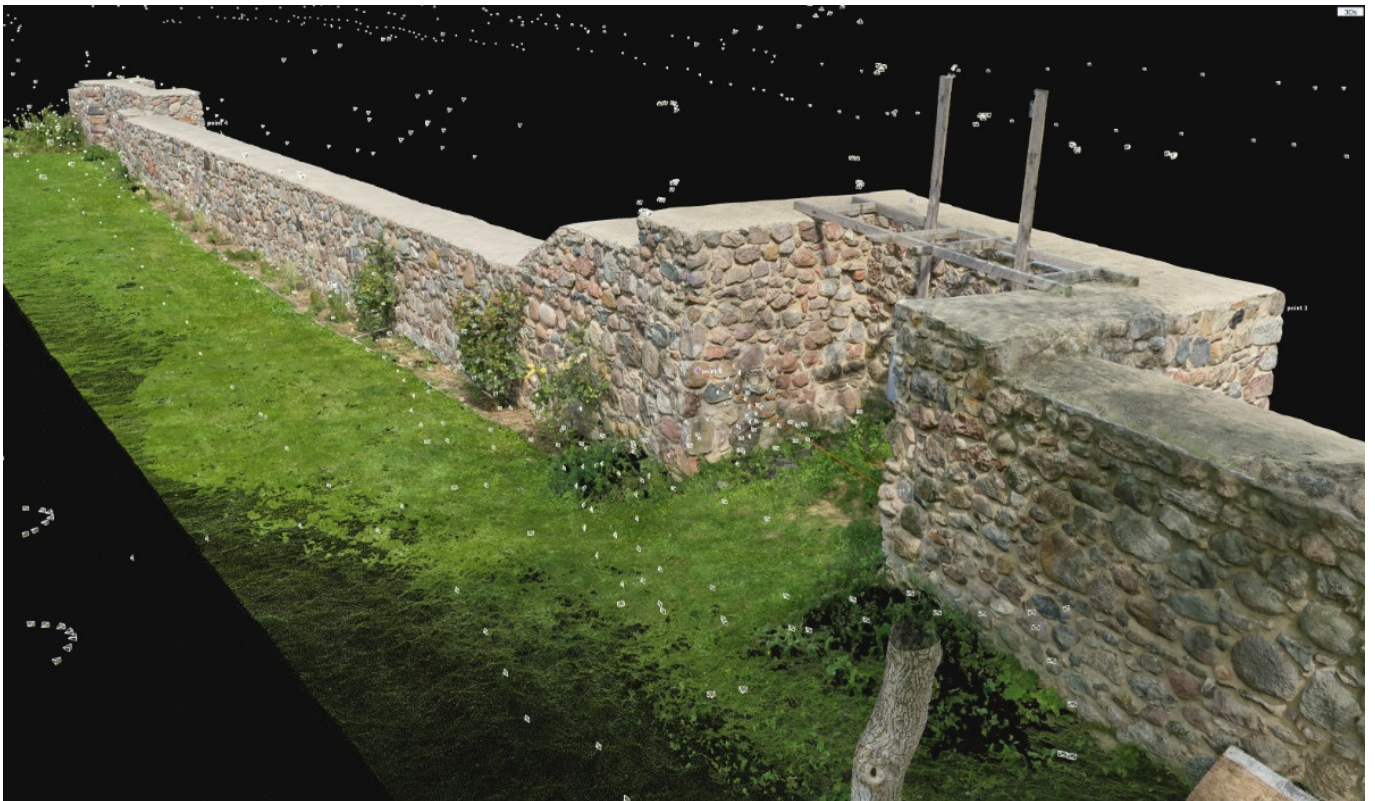
Point cloud image from the photogrammetric model from the city side / Biuro Dokumentacji Zabytków.
