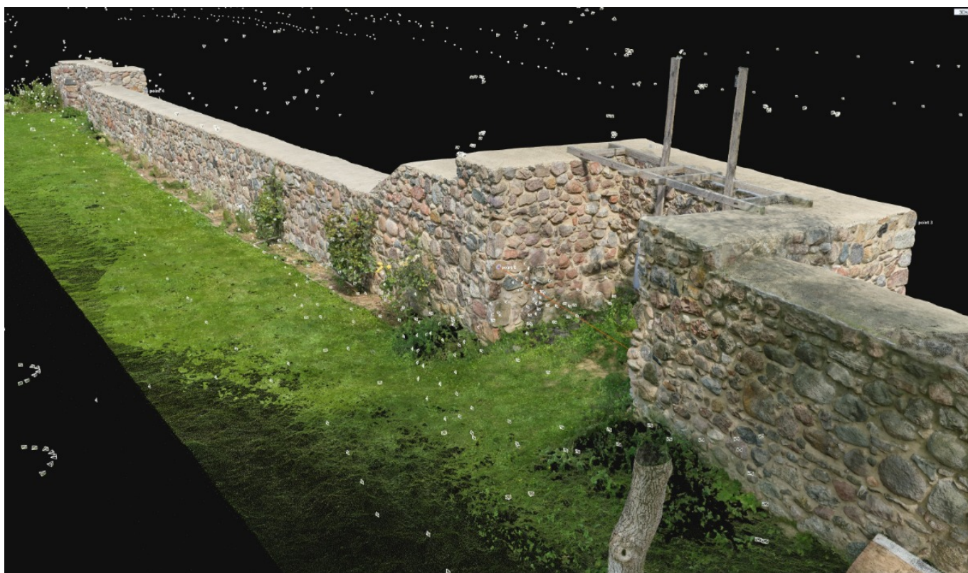
Point cloud image from the photogrammetric model from the city side / Biuro Dokumentacji Zabytków.
