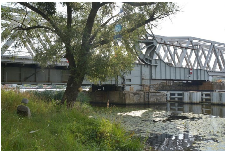
Zabytkowe przęśło mostu kolejowego, w tle nowa przeprawa kolejowa. Fot. A. Bąkowski, 2026
